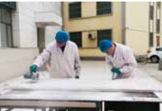
图 8.55 去除原支撑体
