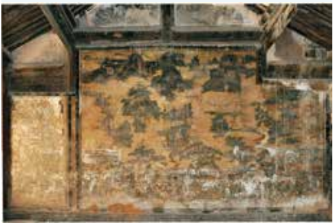
图 17 后殿西壁壁画显示古松槎枒气象
