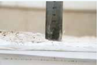
图 8.57 减薄地仗凸起
