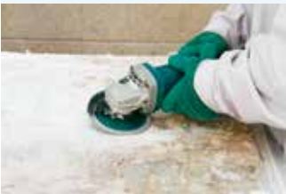
图 8.56 角磨机细微打磨
